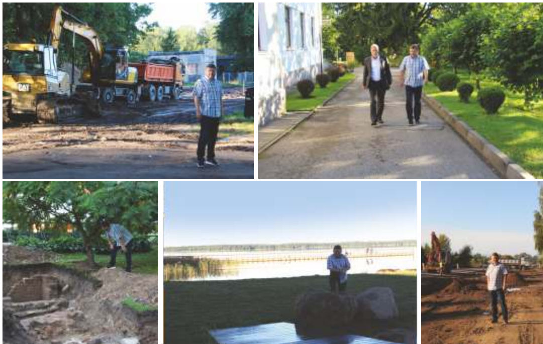
Bačiūnų gatvės rekonstrukcija bei Rėkyvos progimnazijos rekonstrukcija ir priestato statyba
